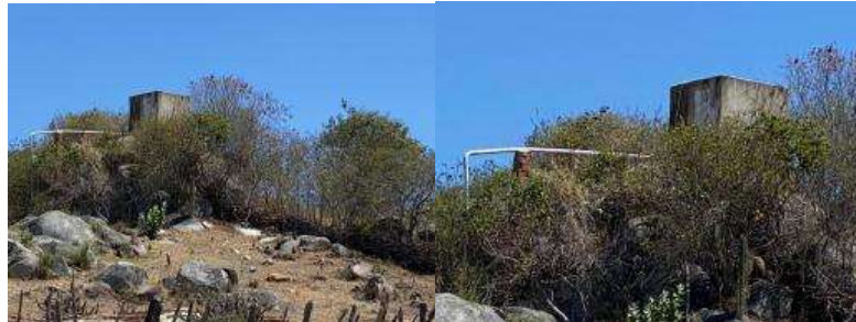
Figura 3 - Imagem ilustrativa do reservatório suspenso
