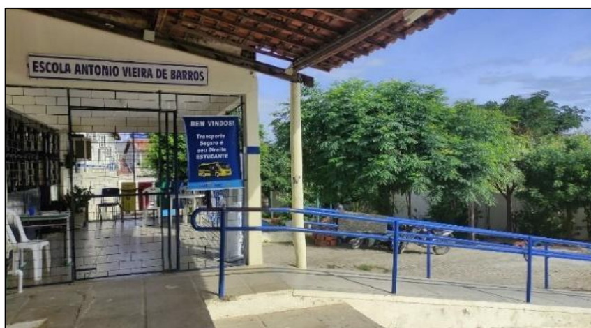
Figura 02: Visão geral da entrada principal do Anexo I da Escola Municipal Osmundo Bezerra, Salgueiro/PE.
