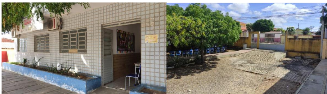
Figura 01: Imagem da Escola (Anexo II) Osmundo Bezerra, Salgueiro -PE
