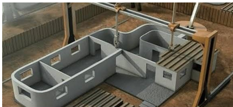
Figura 02: Impressão 3D na construção civil
