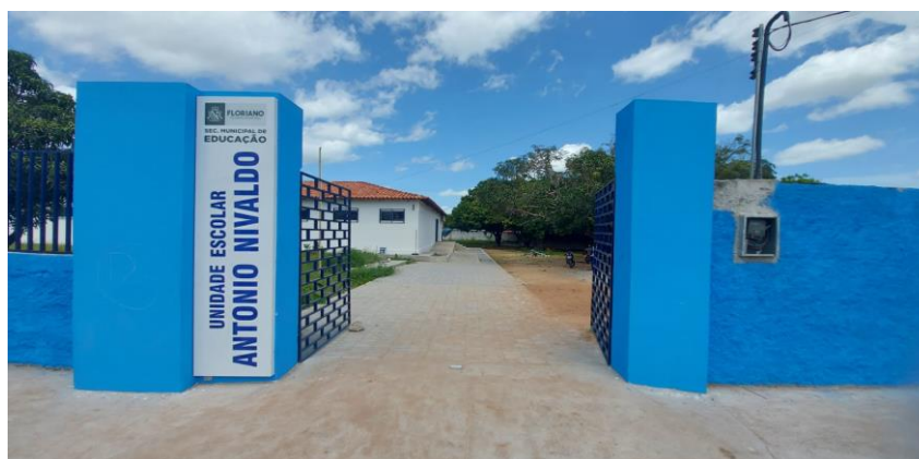
Figura 1: Frente da Escola Municipal Antônio Nivaldo.
