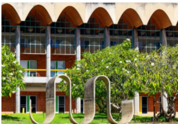
Figura 03 - Fachada sudoeste do prédio da Assembleia Legislativa do Piauí.
